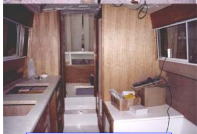
La construction de l'ARECABE II
