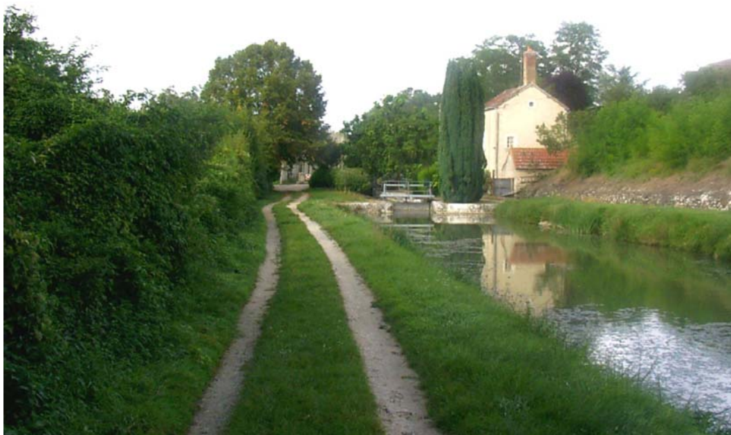
Écluse de la Thizardière
