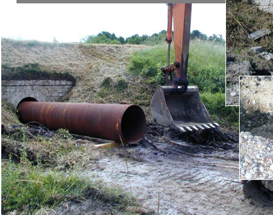
Des travaux rapidement et efficacement effectués.
