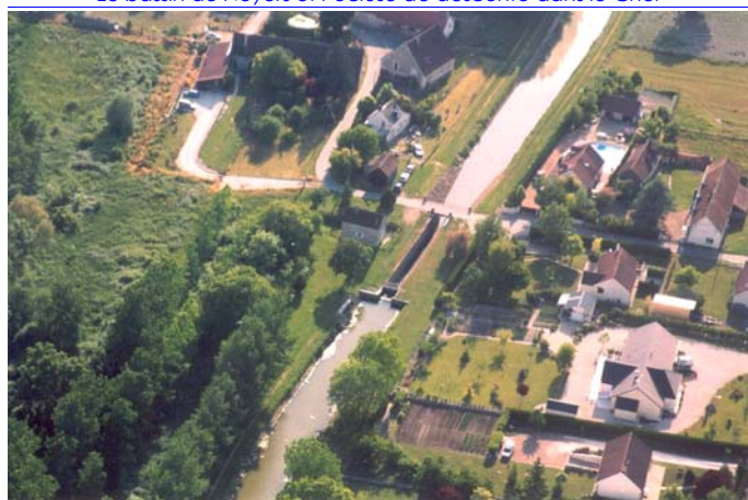
L'écluse des roches
