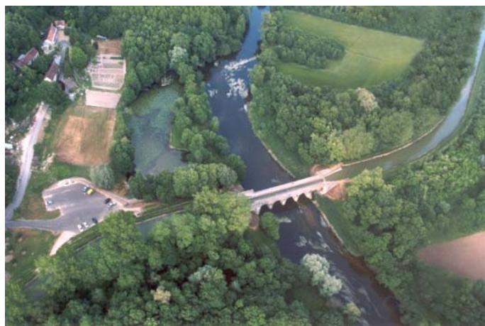
Le pont-canal de Châtillon sur Cher
