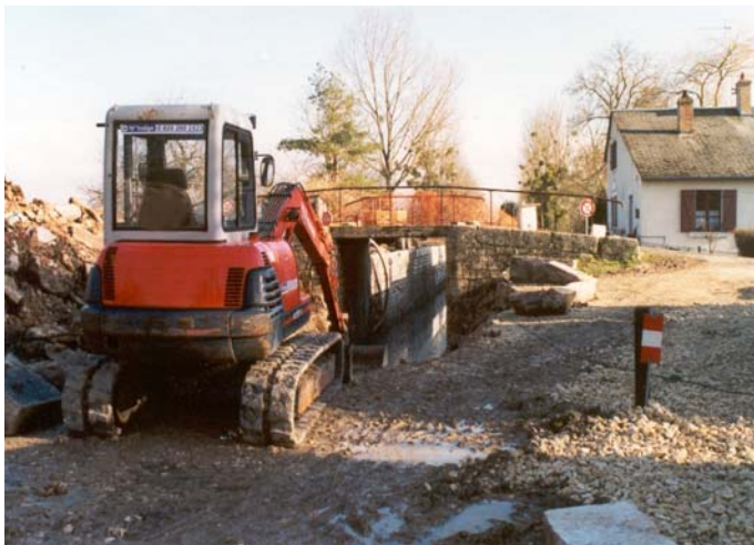
L'écluse de l'Étourneau est en cours de rénovation...
