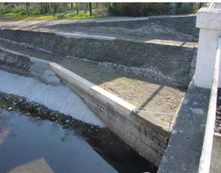
des travaux réalisés par le SMERCAB...
